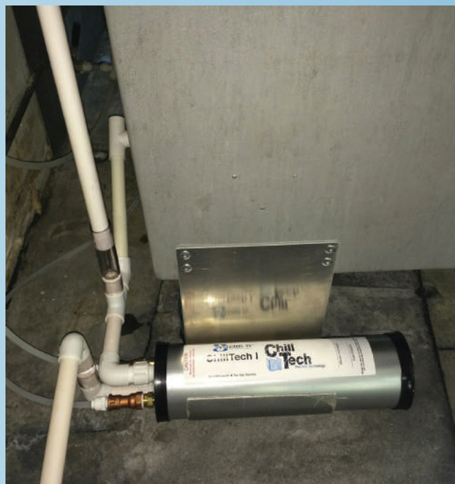
ChillTech I Horizontal Install
